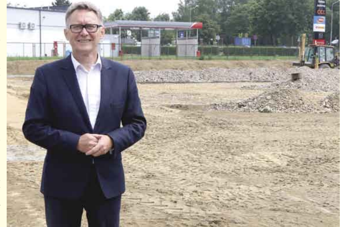
➦ Burmistrz na placu budowy boiska sportowego przy Gimnazjum nr 1
